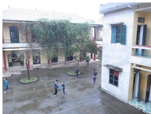
写真1 ナムディン省ロクアン社の複合施設 (二階から見た施設内の様子)
